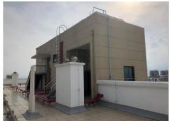
照片6 梯间东南侧
